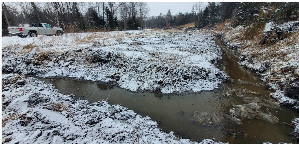
Figure 4. Canal de déviation de l'eau aménagé le 8 janvier 2025
