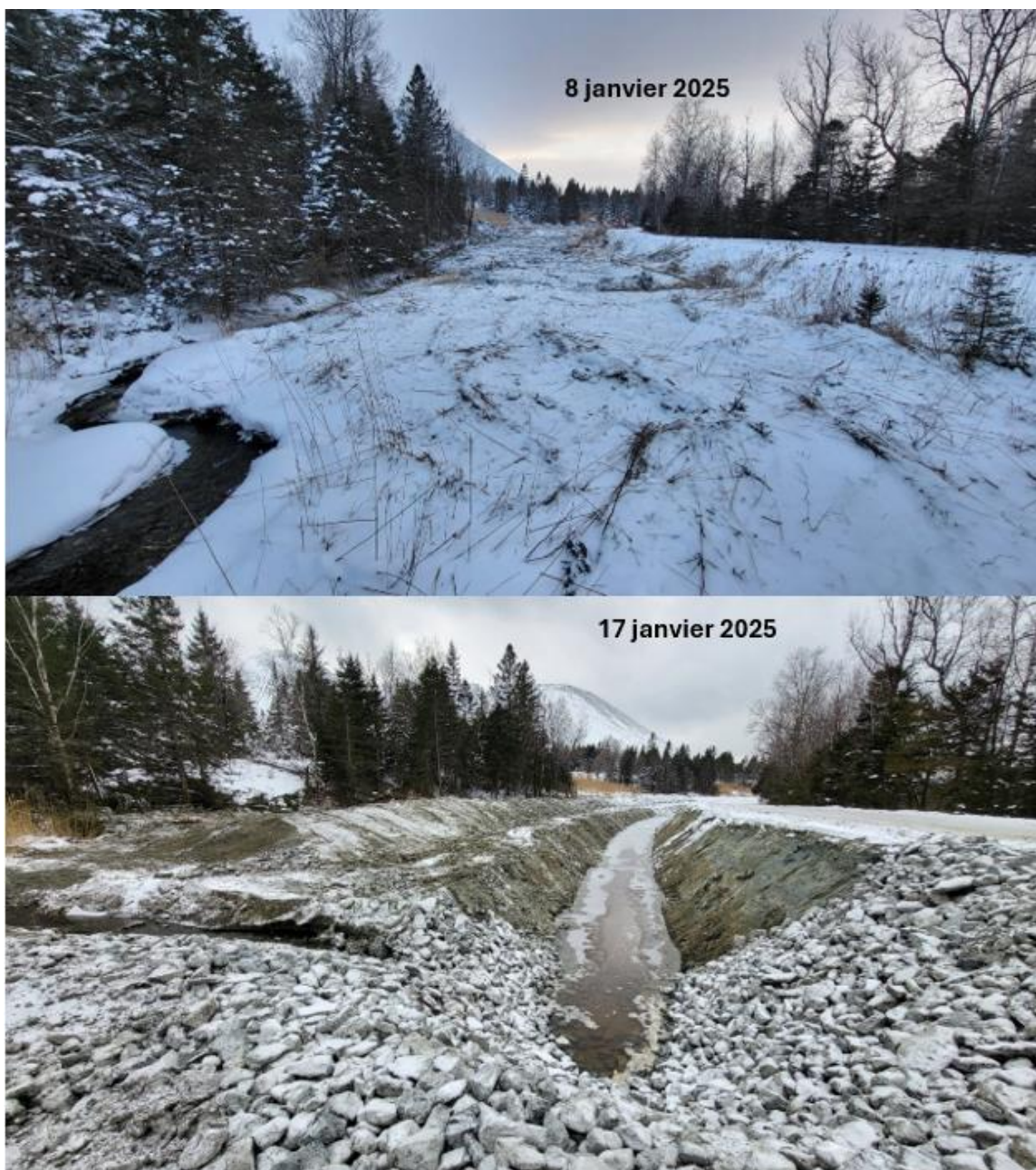
Figure 27. Avant après de l'excavation du bassin Normandie à partir de l'entrée
