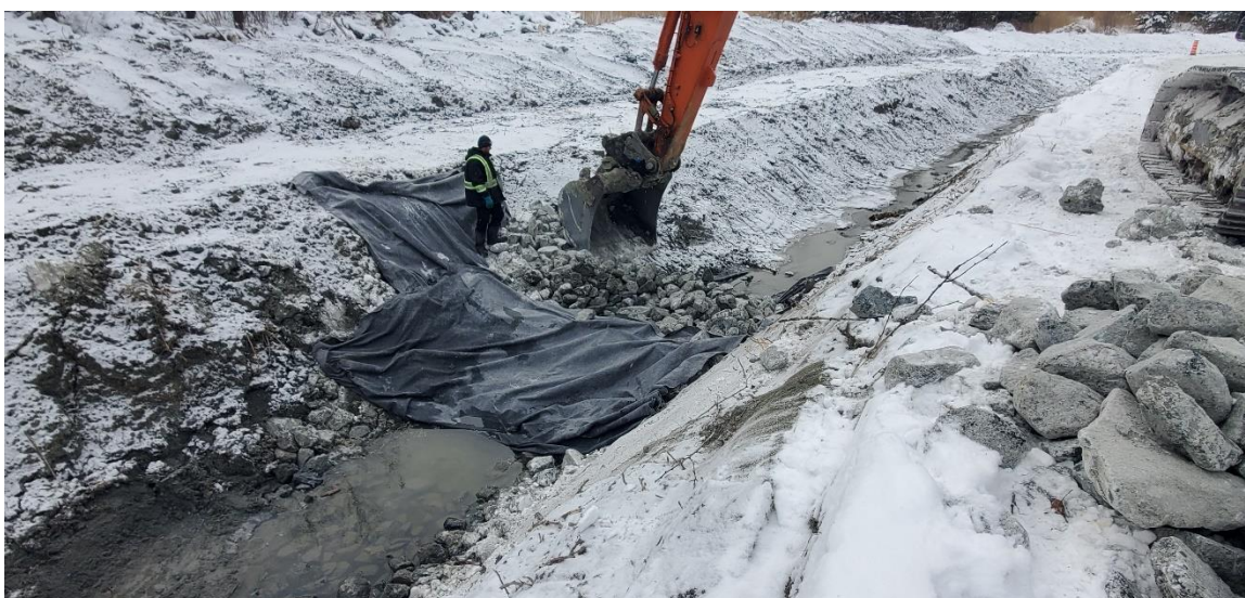
Figure 12. Aménagement de la berme filtrante à 160 mètres (suite)
