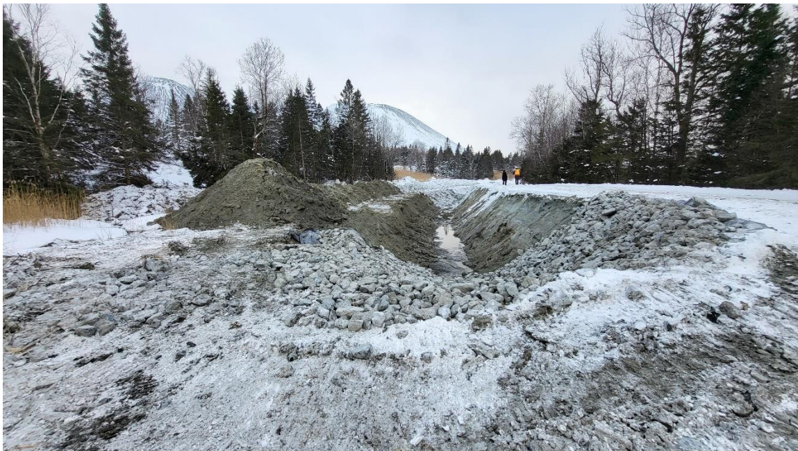
Figure 15. Vue à partir de l'entrée du bassin
