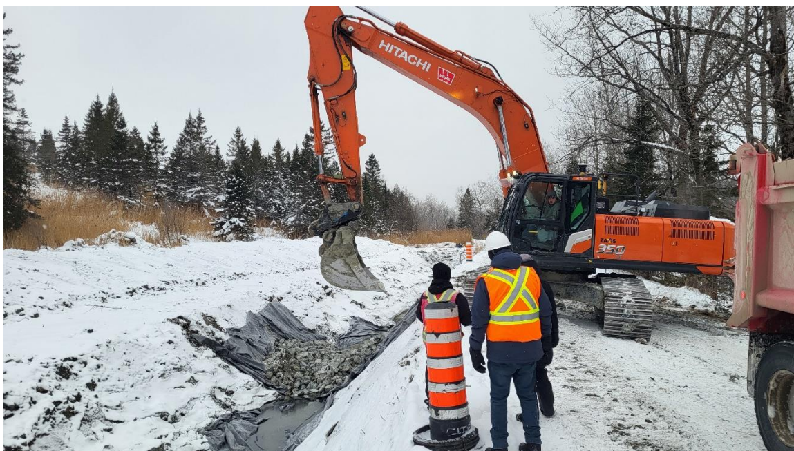
Figure 13. Aménagement de la berme filtrante à 160 mètres, avec la pelle mécanique
