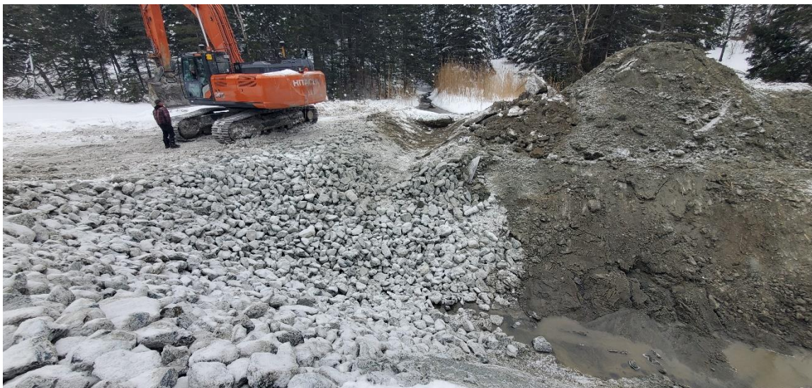
Figure 17. Excavation de l'entrée du cours d'eau vers le bassin
