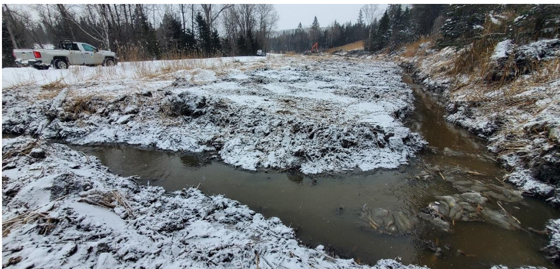
Figure 7. Excavation du canal de déviation d'eau
