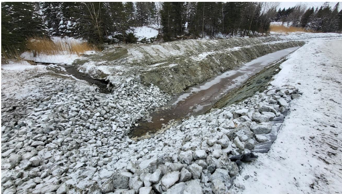
Figure 20. Entrée du bassin de sédimentation Normandie
