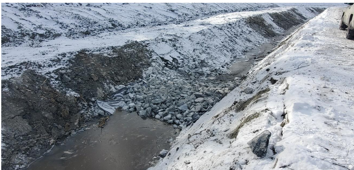
Figure 18. Berme filtrante à 70 mètres en fonction
