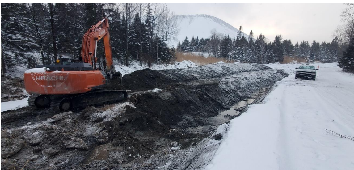
Figure 9. Suite de l'excavation du bassin
