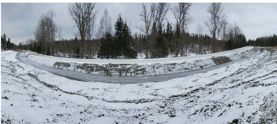
Figure 25. Panorama du bassin de sédimentation Normandie à la fin des travaux 2025
