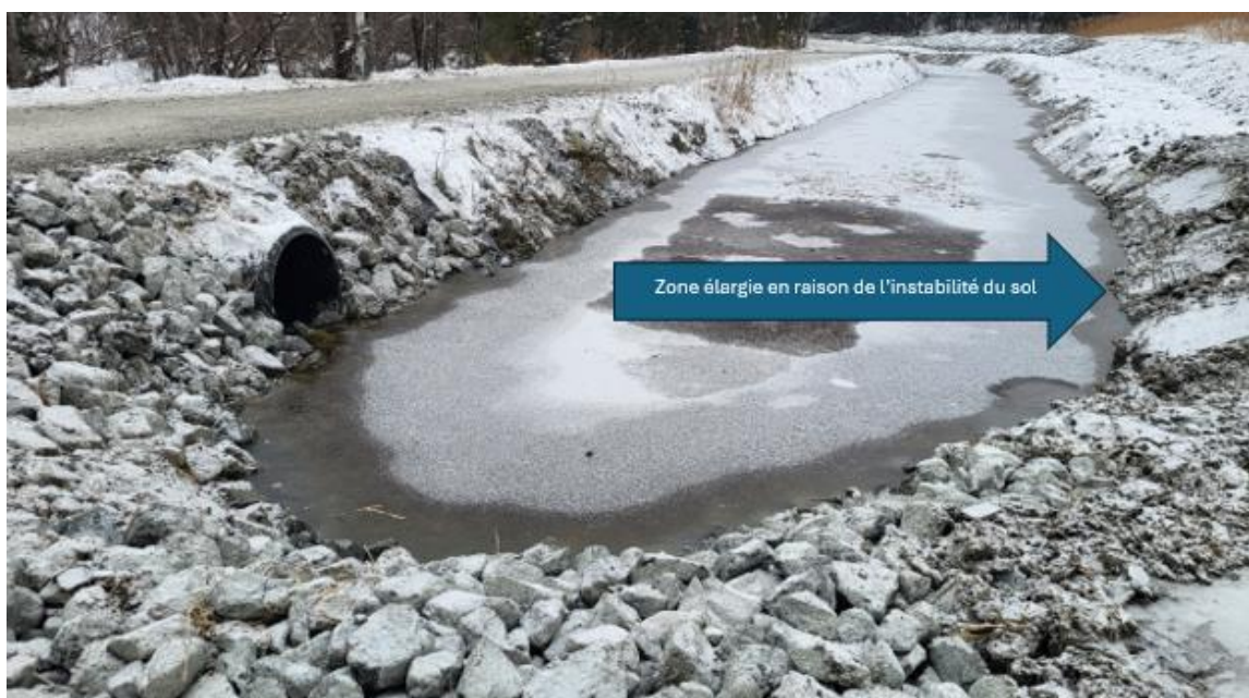
Figure 23. Sortie du bassin
