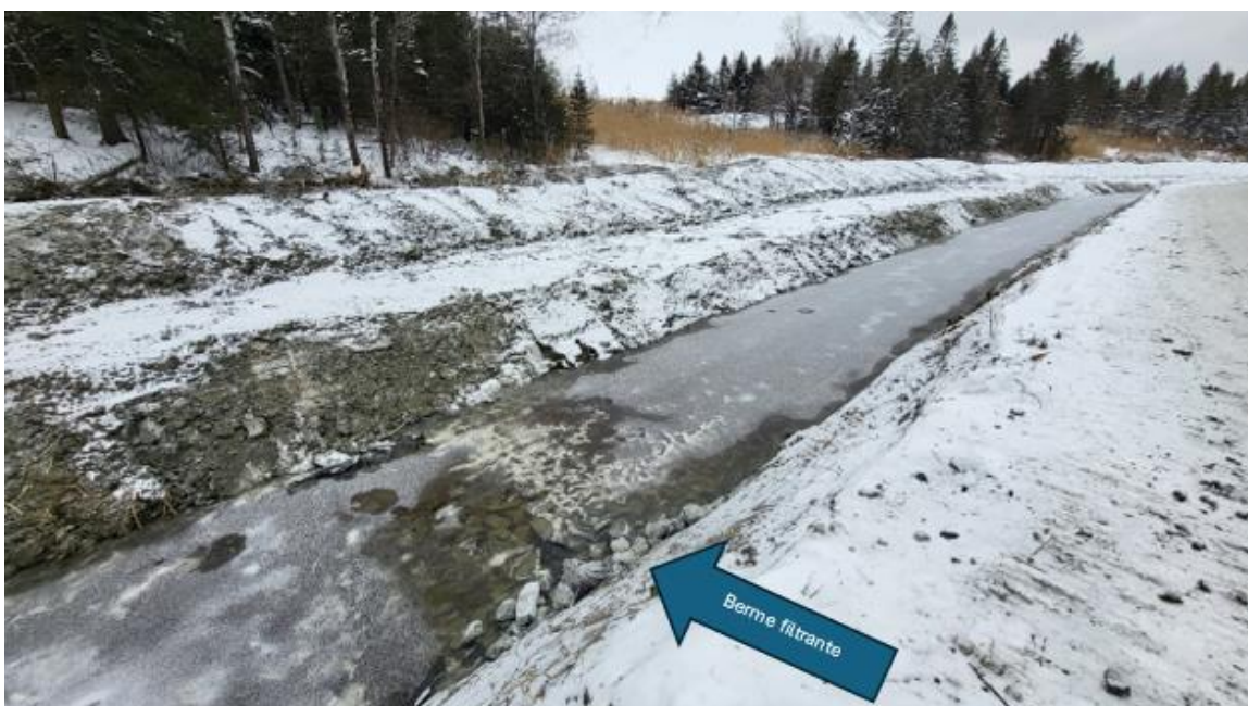
Figure 21. 1 ère berme filtrante en fonction
