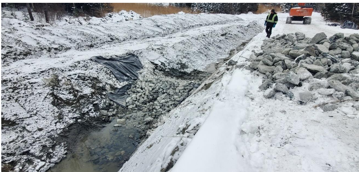
Figure 14. Aménagement de la berme filtrante à 70 mètres
