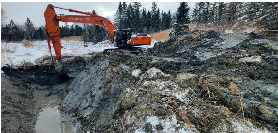
Figure 8. Début de l'excavation du bassin à partir du ponceau (en aval)
