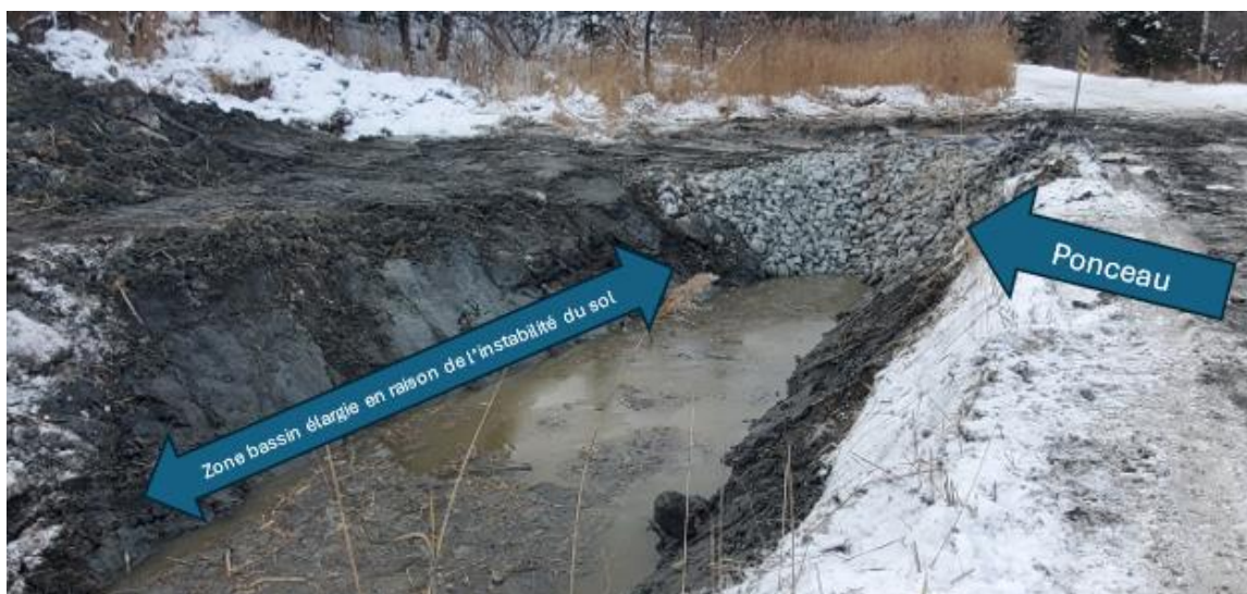
Figure 19. Aménagement de la sortie du bassin
