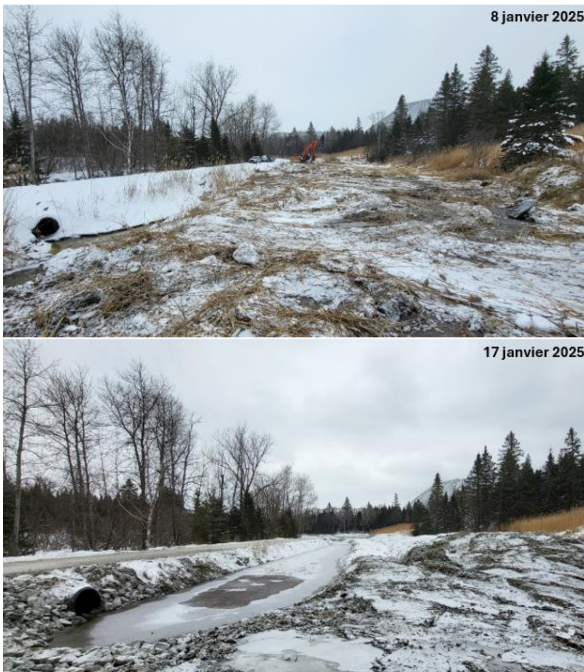
Figure 26. Avant après de l'excavation du bassin Normandie à partir du ponceau
