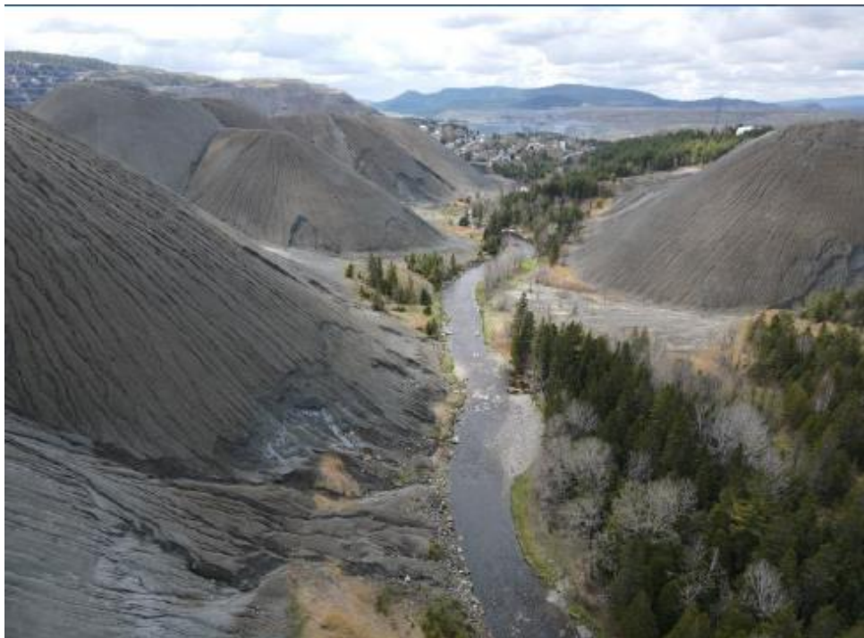
Figure 2: Photo aérienne de la rivière Bécancour s'écoulant entre des haldes minières et érodant ces dernières.
