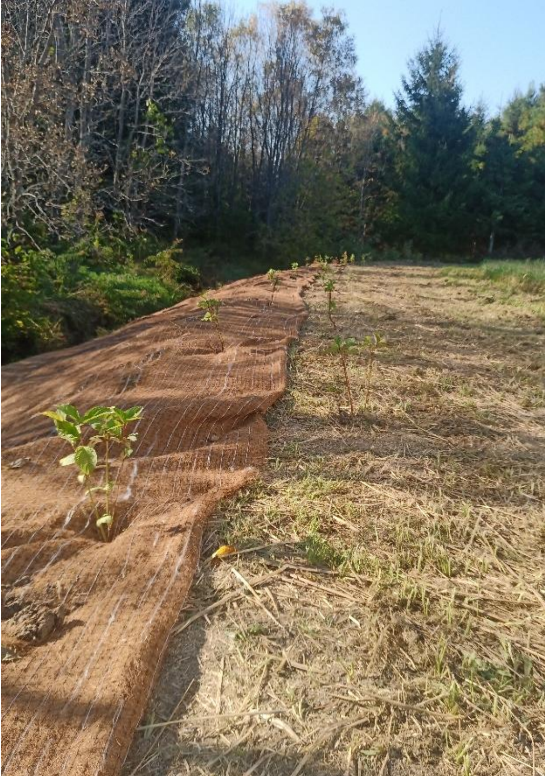
Figure 22. Travaux de stabilisation et de plantation le lot 3 294 418 dans le bassin de la rivière Gentilly, dans la municipalité de Bécancour (2025).
