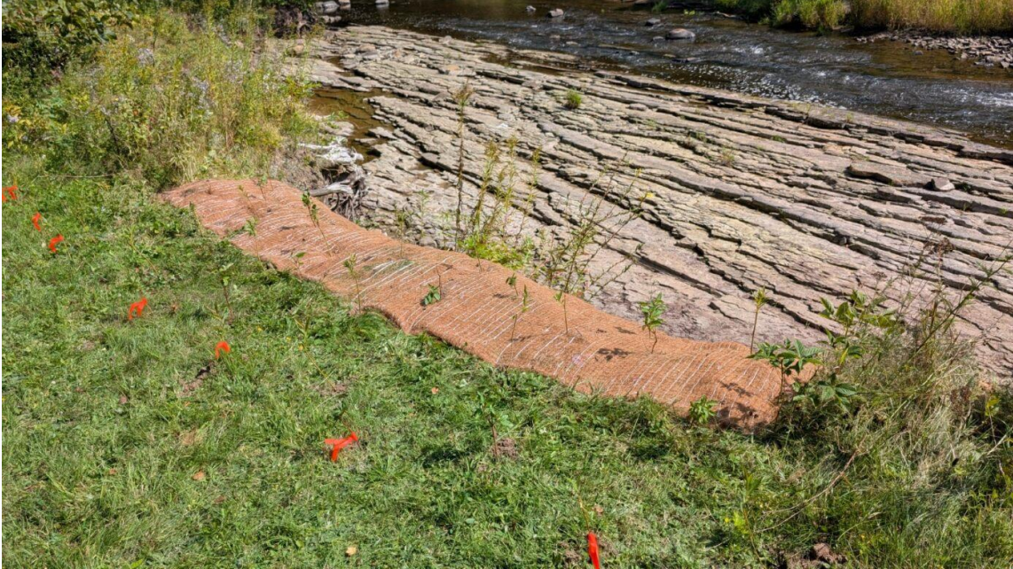
Figure 9. Travaux de stabilisation et de plantation sur le lot 6 180 259 dans le bassin de la Petite rivière du Chêne, dans la municipalité de Fortierville (2025).
