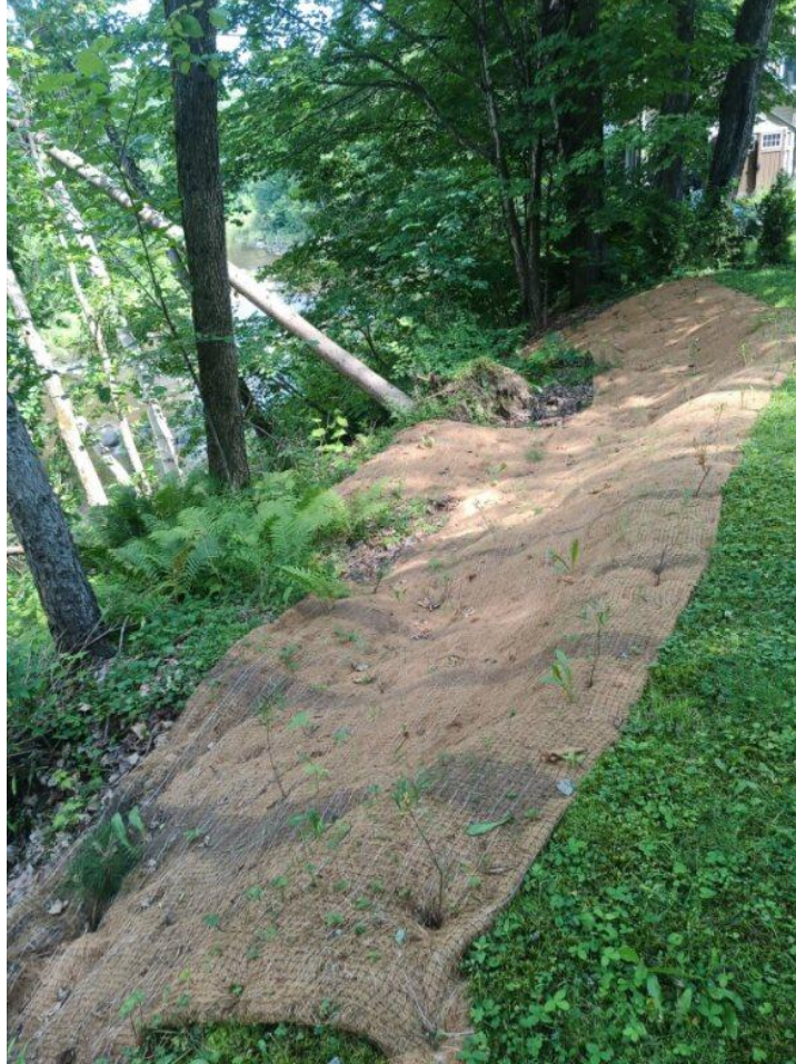
Figure 6. Travaux de stabilisation et de plantation sur le deuxième site du lot 6 084 132 dans le bassin versant de la Petite rivière du Chêne, dans la municipalité de Deschaillons-sur-Saint-Laurent (2025).
