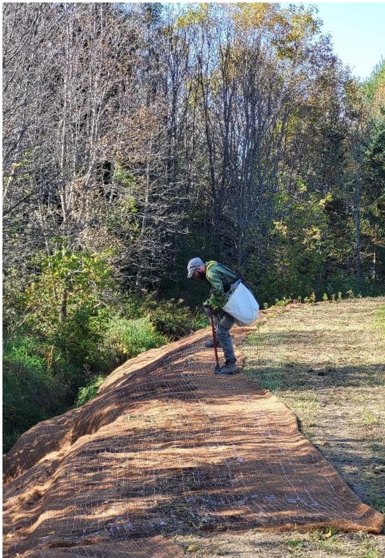
Figure 21. Travaux de stabilisation et de plantation sur le lot 3 294 418 dans le bassin de la rivière Gentilly, dans la municipalité de Bécancour (2025).
