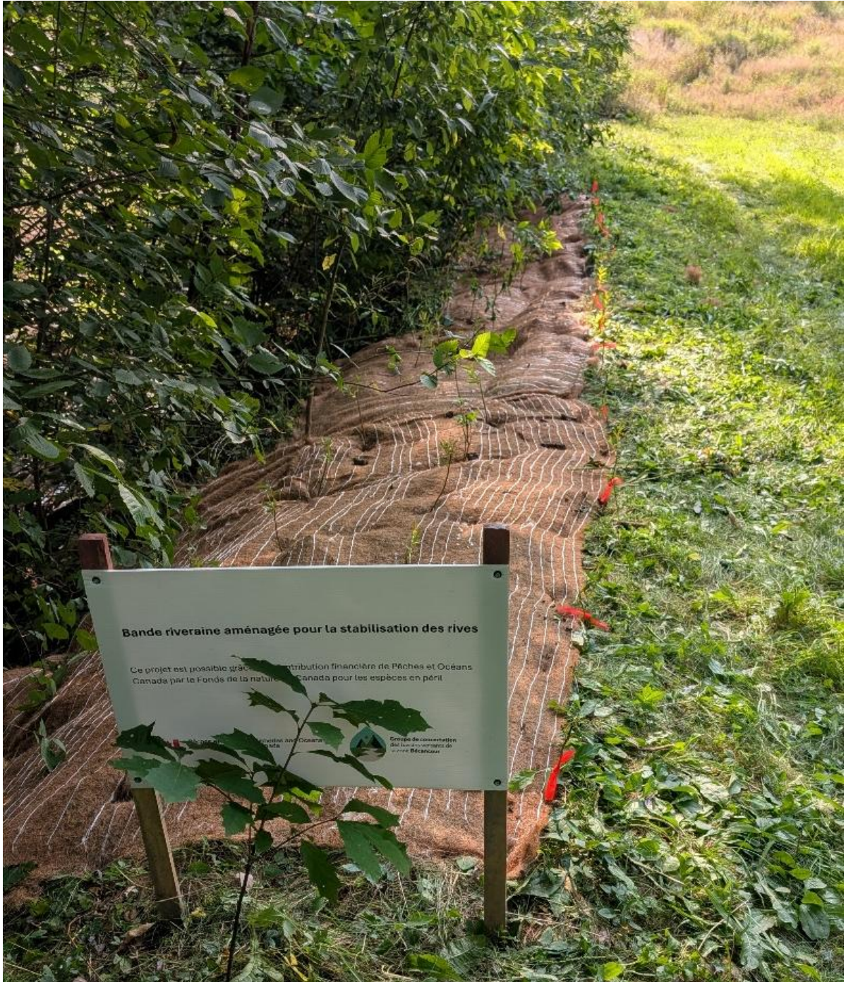
Figure 4. Travaux de stabilisation et de plantation sur le lot 3 294 350 dans le bassin de la rivière Bécancour dans la municipalité de Bécancour (2025).
