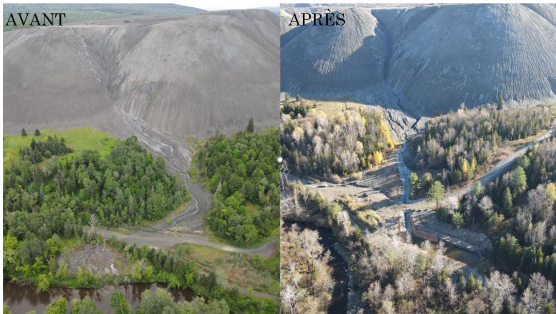
Figure 10 La photo de gauche présente le parcours de l'écoulement drainant la halde de MRA avant les travaux. Son épanchement en rive de la rivière Bécancour en bas de la photo avait tué la bande végétale arborescente riveraine. La photo de droite présente le nouveau tracé de l'écoulement redirigé vers le bassin aménagé dans un ancien fossé longeant la digue riveraine de la rivière Bécancour. Son effluent rejoint la rivière par un ponceau aménagé sous la digue.
