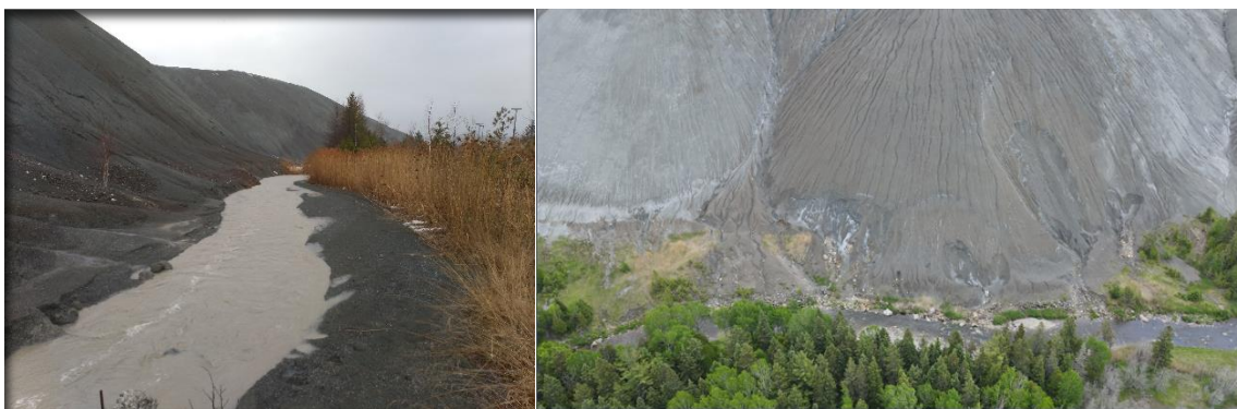
Figure 22 Zone d'érosion directe par le ruisseau British Canadian longeant une halde de la mine British Canadian (à gauche) et zone d'érosion directe par la rivière Bécancour d'une halde de la mine British Canadian (à droite).
