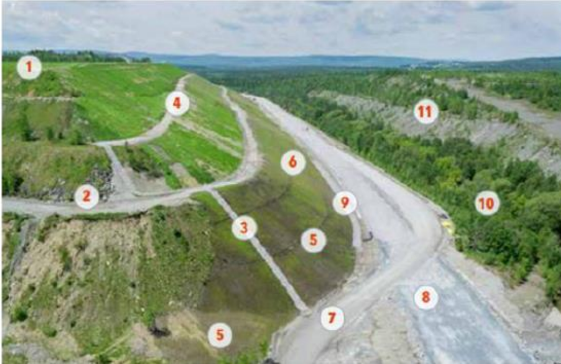
Figure 32 Reprofilage d'une halde dans le cadre des travaux de construction de la route 112. Tiré de Norda Stelo et Snc-Lavalin, 2019.
