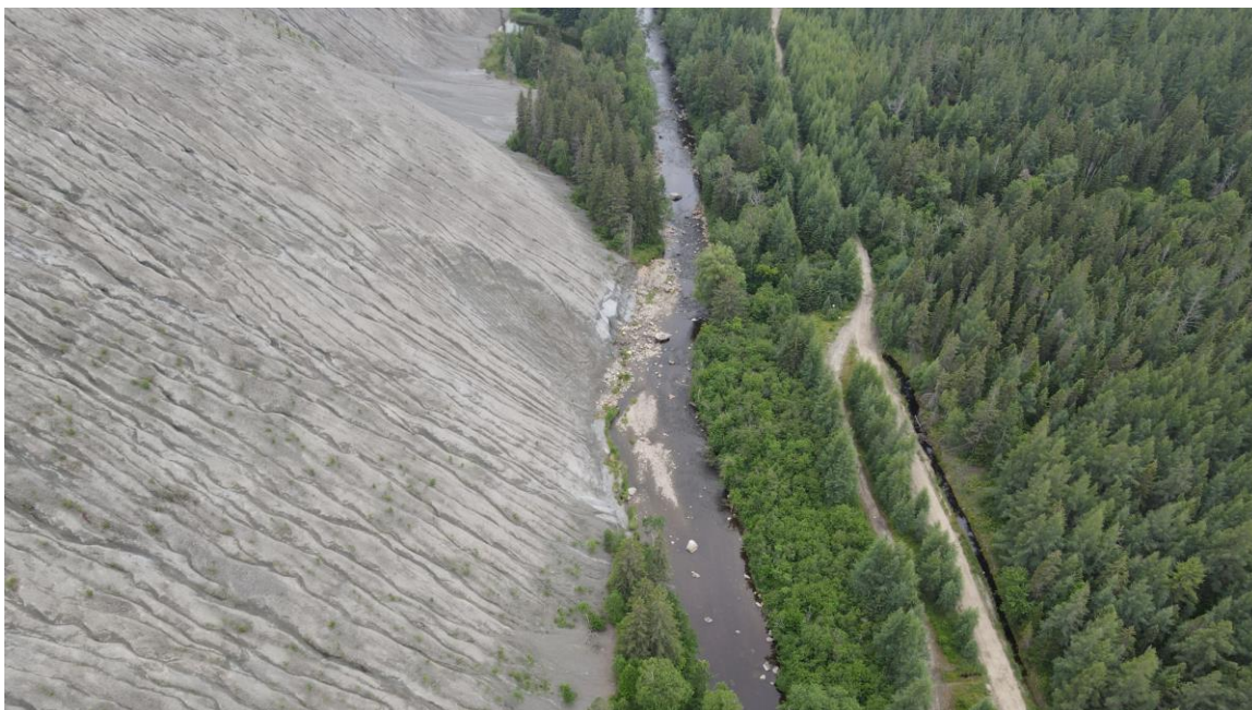
Figure 20 Zone d'érosion directe par la rivière Bécancour de la halde de RMA de la mine King Beaver à Thetford Mines.
