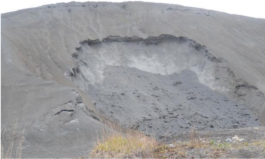
Figure 5 Décrochement majeur sur la haldé de RMA de BC 1
