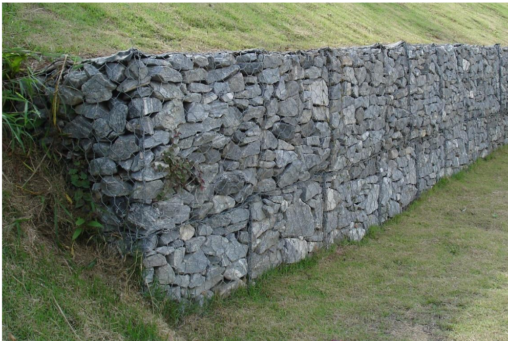
Figure 34 Exemple de gabions installés pour stabiliser une pente, Source : Eurico Zimbres
