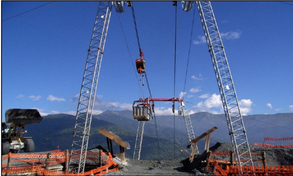
Figure 31 Photographie d'un téléphérique utilisé pour le reprofilage d'haldes minières à la mine Balangero en Italie, tiré de Oboni et al., 2011
