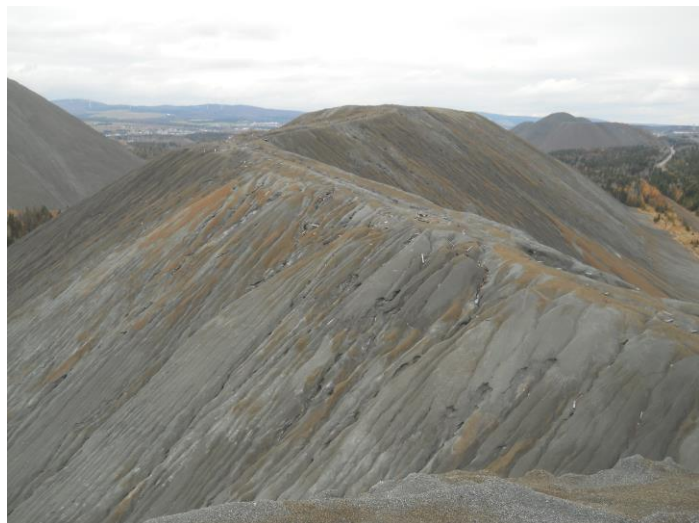
Figure 10 Érosion, Halde de la mine Crabtree BC1#1
